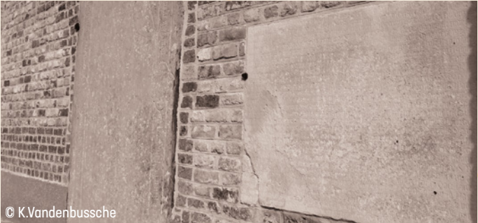
De steen met het testament bevindt zich in de zuidelijke gevel van de kerk. Ernaast werd het 16de-eeuwse grafmonument van de familie Nocke ingemetseld.
