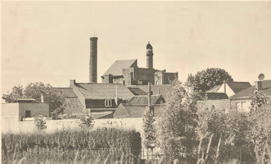
De schoorsteentorens van Brouwerij Louwaege
